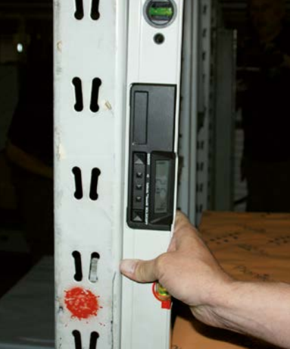
Abb. 10 Messung der Schiefstellung mit digitaler Wasserwaage
