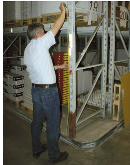
Abb. 6 Überprüfung der Fachhöhe
