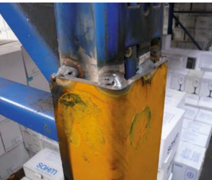
Abb. 11 Unfachmännisch geschweißte Stütze
