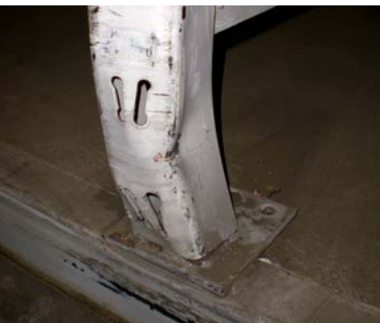
Abb. 12 Gerissene Schweißnaht an der Fußplatte der Stütze
