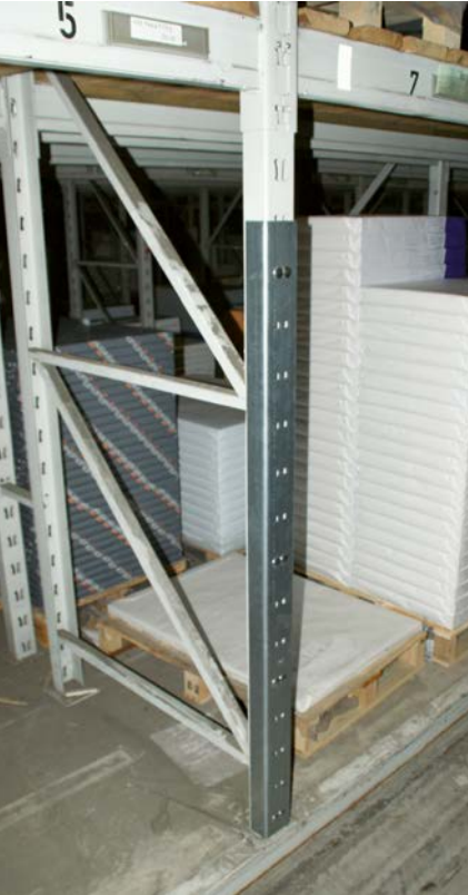
Abb. 18 repariertes Regal: nach dem Richten wurde die Stütze mit einer Verstärkung versehen
