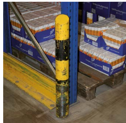
Abb. 14 Besonders stabil ausgeführter Anfahrerschutz
