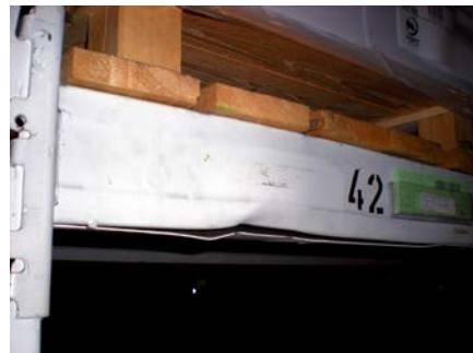
Abb. 9 Beschädigter Regalträger
