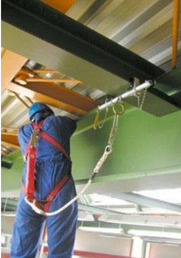
Bild 8: Beispiel eines Auffangsystems mit Falldämpfer
