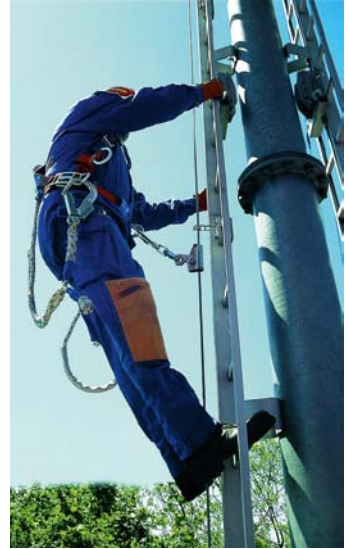
Bild 20: Beispiel einer Steigschutzeinrichtung mit Führung aus Stahldrahtseil
