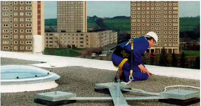
Bild 32: Durch Eigengewicht gehaltene Anschlageinrichtung (z.B. Betongewichte)
