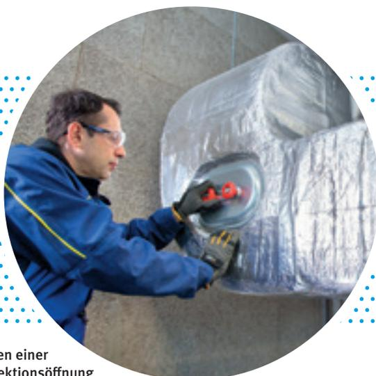
Öffnen einer Inspektionsöffnung zur Kontrolle der Luftleitung
