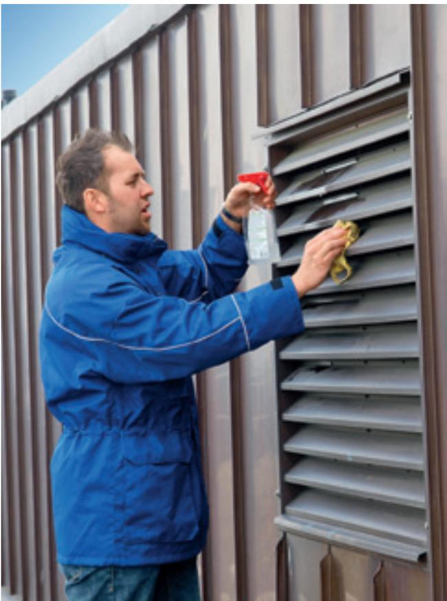
Reinigung einer Außenluftansaugöffnung
