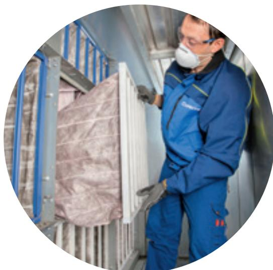
Ausbau eines gebrauchten Luftfilters
