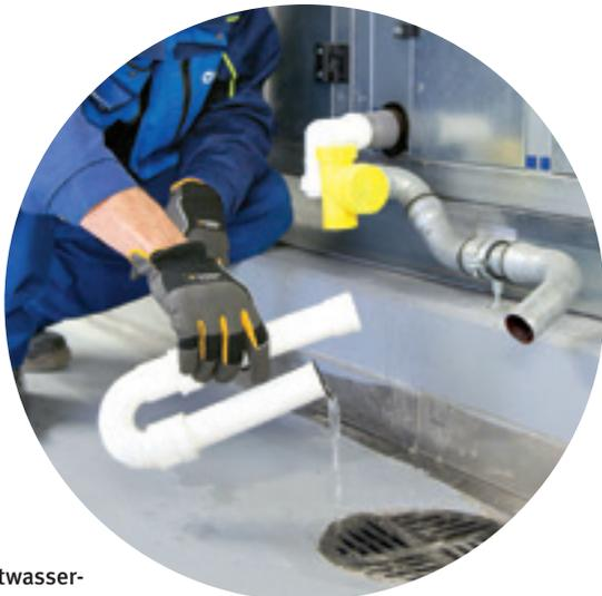
Kondensatwasserentleerung aus einem Syphon
