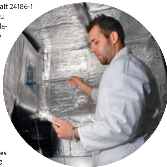
Messung des Luftvolumenstromes in einer Luftleitung
