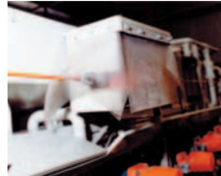
Bild 3-6: Reißleine, der Schalter wurde wegen möglicher Verschmutzung und gegen Spritzer abgedeckt
